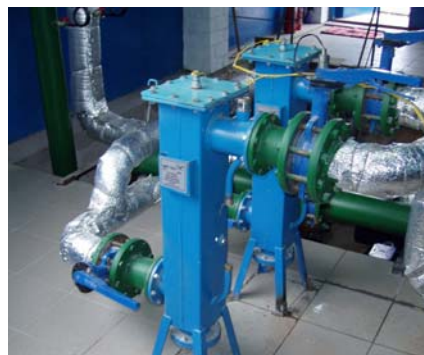
Установка ЩИТ-5/2У на котельні м. Мелітополь
